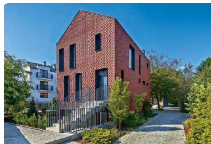
► Mikrokamienica (zdobywczyni Nagrody Roku SARP 2023, umieszczona na liście Muratora TOP 10+1 najpiękniejszych domów 2021 r.) otwiera zabudowę wąskiej parceli i osłania Dom z Jabłonią od ulicy
