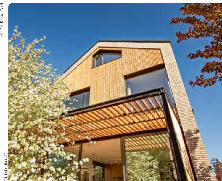
► Lamele pergoli zostały ustawione pod takim kątem, aby zagwarantować intymność na tarasie, ale nie odcinać dopływu naturalnego światła
